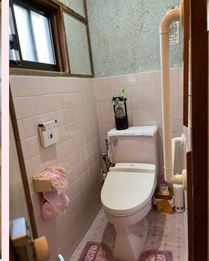
歩行補助のため自宅に手すりを設置
